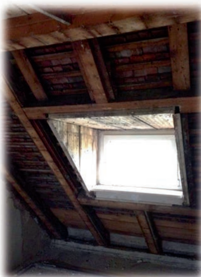
Wohnraum vor der Modernisierung
