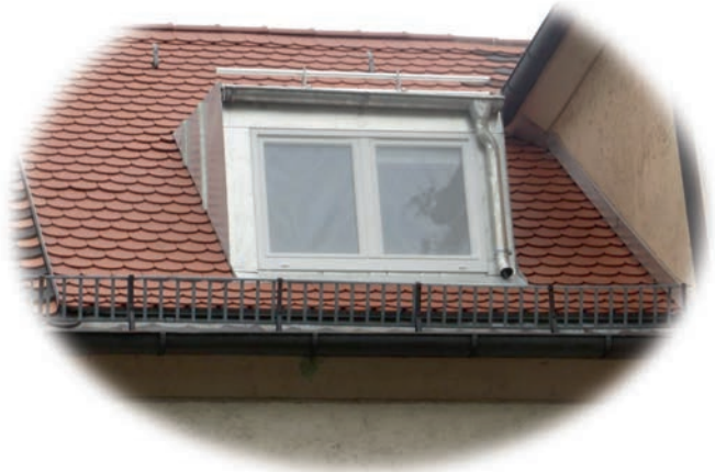
Dachgaube nach dem Umbau
