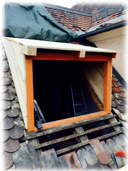
Dachgauben während der Umbauphase
