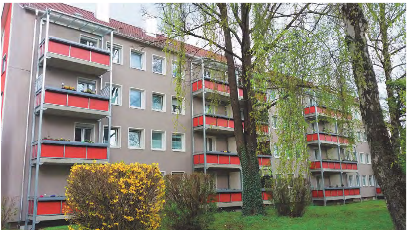
Rappoltsteiner Straße 8-12, nach Beendigung der Baumaßnahme
